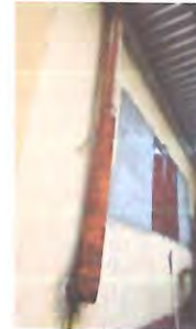
Foto 2: REPARACIÓN O SUSTITUCIÓN DE ÁREA DE COCINA sustitución de chimenea para estufa rural
