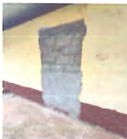
Foto 5: REPARACIÓN DE REPELLO Y CERNIDO DE PAREDES Reparación de repello y cernido en muro de mampostería con aplicación de acabado uniforme. Bodega, cocina, pared de aula grande a la par de cocina
