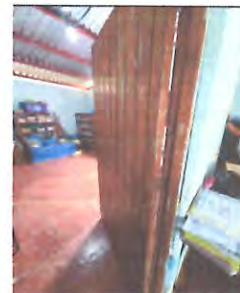
Foto 6: PUERTAS Suministro e instalación de puerta metálica, incluyendo chapa, bisagras.
