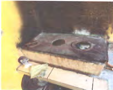
Foto 3: REPARACIÓN O SUSTITUCIÓN DE ÁREA DE COCINA sustitución de plancha para estufa rural.
